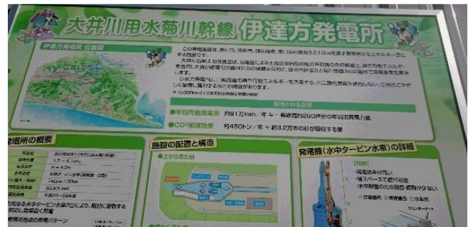
伊達方にある大井川用水の流れをそのまま利用した小水力発電所。約280件分の電気が安定的に地域に配電されています。
