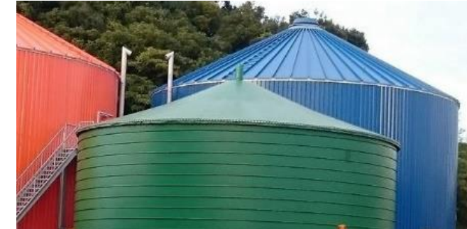
牧之原市にあるバイオマス発電所。食物リサイクル法に基づいて受け入れた県内企業からの食品廃棄物を発酵させメタンガスを作り出して800世帯以上の発電をしています。
