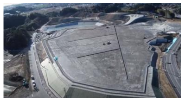
大坂・土方工業団地造成工事
